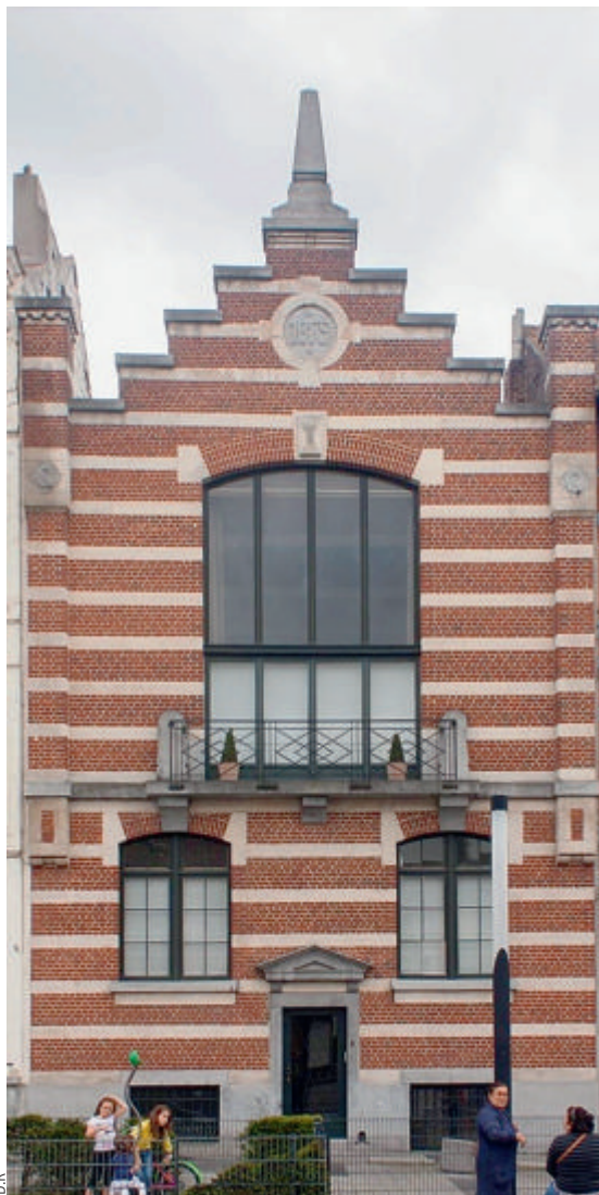
L’atelier Guffens, place Lehon, offre un exemple de verrière positionnée pour recueillir la froide lumière du nord.
